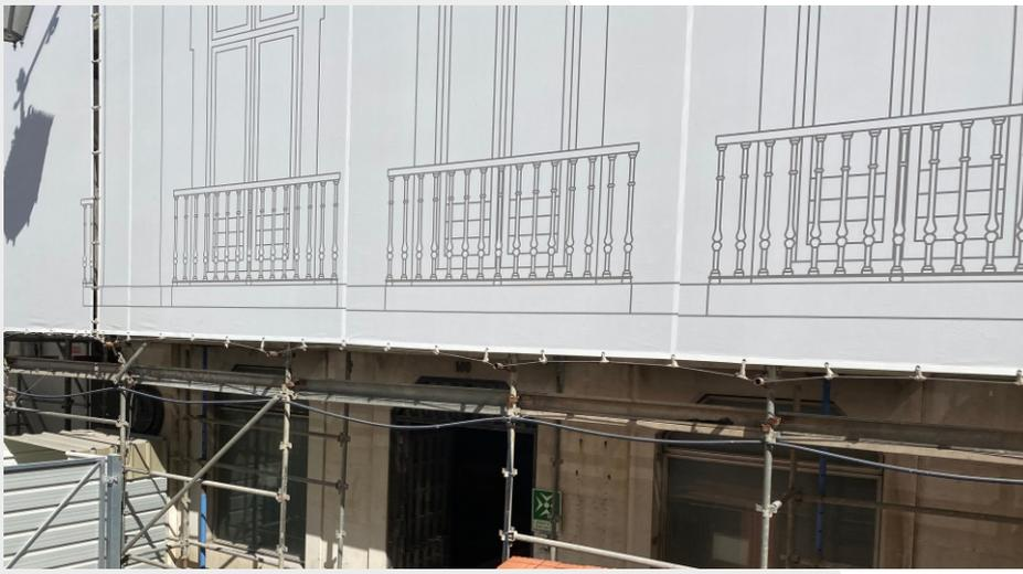
Infine il materiale deve essere termosaldato nei vari pezzi e rinforzato perimetralmente in modo che gli occhielli in alluminio applicati consentano una maggiore resistenza. Il resto per ottenere una ottima installazione dal punto di vista estetico, di sicurezza e durata nel tempo dipende dalle capacità degli installatori e dai metodi utilizzati in fase di installazione.
