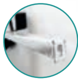
Fissaggio della struttura al muro
