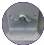
Fissaggio con galletto e bullone
