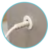
Foro di alimentazione
